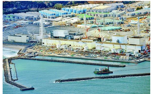
現在の福島原発1～4号機の原子炉建屋(手前右から1、2、3、4号機)。山側には構内の森を伐採して設置された放射能汚染水タンクが並ぶ(2月25日撮影(しんぶん赤旗より))
